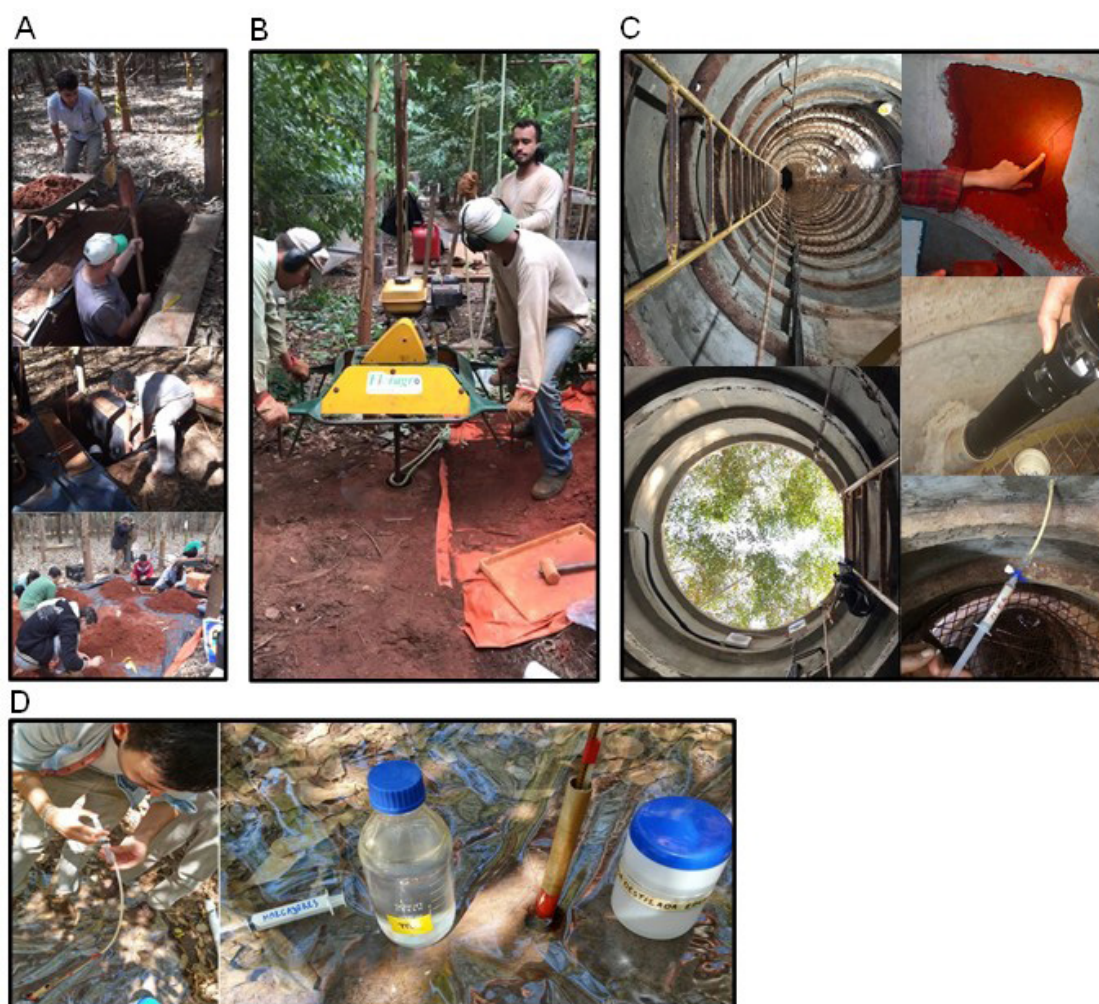
Figura 1. Ilustrações de diferentes métodos de campo para estudar raízes profundas. (A) Abertura de trincheiras, (B) trado mecanizado, (C) trincheiras de concreto até 17 m de profundidade com janelas de observações, instalação de tubos de MiniRizotrons e de seringas para coletar gases ( \text{CO}_2 , \text{N}_2\text{O} e \text{CH}_4 ), (D) aplicações de marcadores ( \text{NO}_3^{-15}\text{N} , \text{Rb}^+ , \text{Sr}^{2+} ) à diferentes profundidades no solo.
